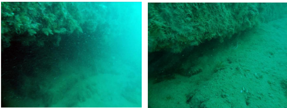
Εικόνα 3.3 : Τμήμα εκτεταμένων υποσκαφών μπροστά από τον κρηπιδοτόιχο
