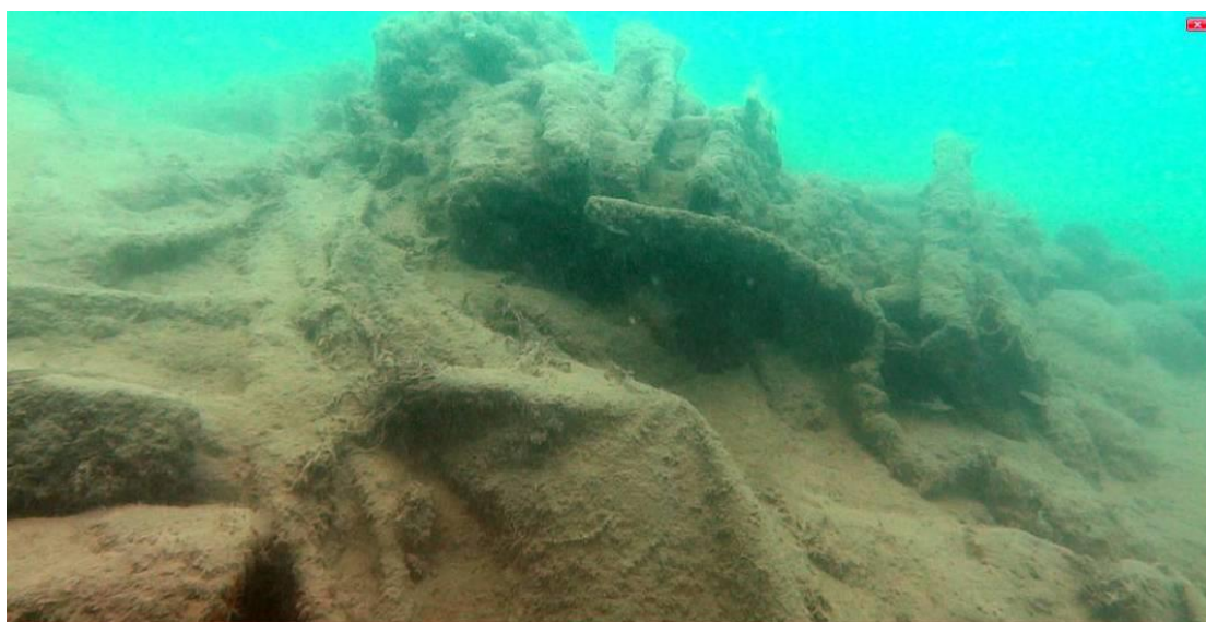
Εικόνα 3.4: Γεωύφασμα που κείται επί του πυθμένα σε απόσταση 3 – 4 μέτρων από τον κρηπιδοτόιχο
