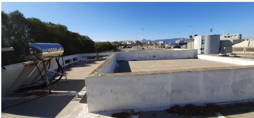
Φωτογραφία 5 Δώμα πυροσβεστικού σταθμού
