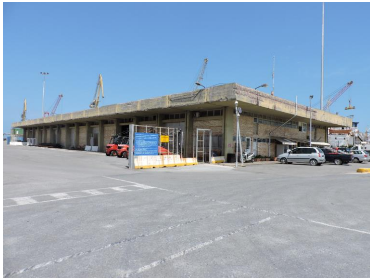
Φωτογραφία 1 Κτίριο αποθηκών
