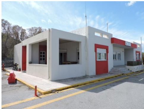
Φωτογραφία 3 Πυροσβεστικός σταθμός
